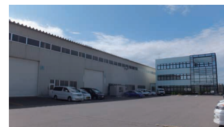
江南工場全景
