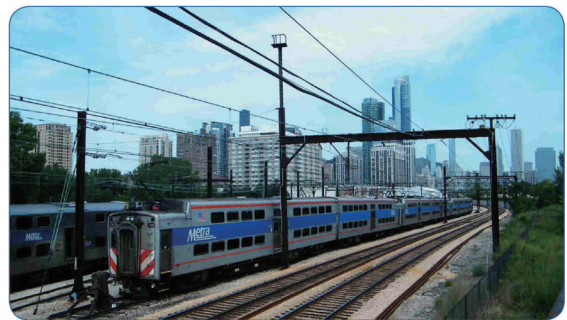
メトラ エレクトリック線（複々線区間） （メトラパンフレットから転載）
