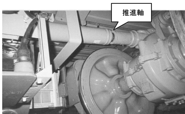
写真1 推進軸の取付け状態
