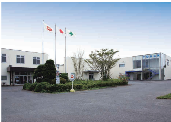
茨城工場外観
